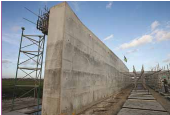
Hanzelijn in aanbouw
